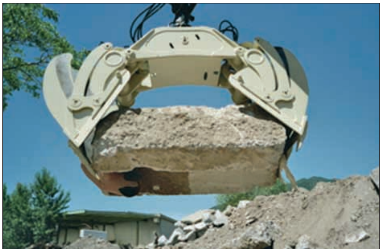
... effectuer de lourds travaux d'encrochement avec, c'est unique au monde, des prises pouvant aller jusqu'à 2,5 tonnes.
