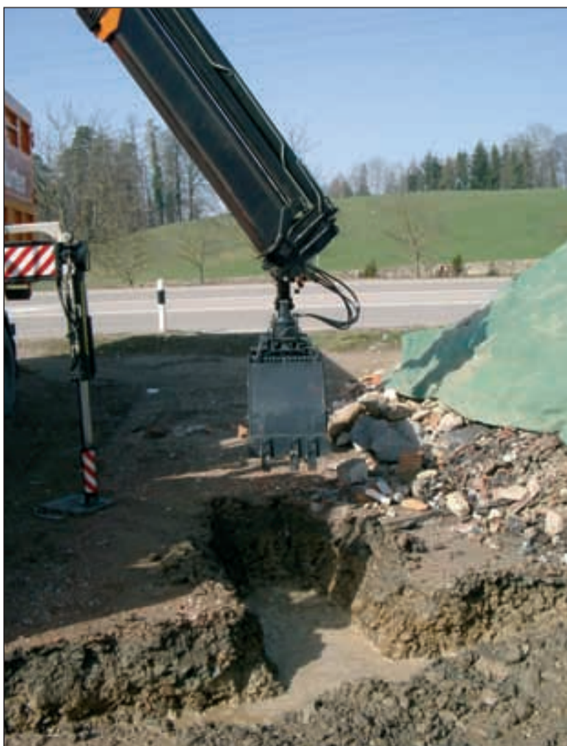
Le Grapner creuse, excave en terrains meubles ou durs et il peut aussi...
