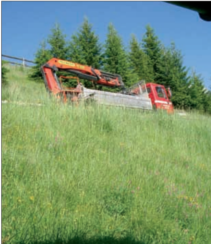
Là où un trax ou autres machines de chantier auront de la peine à accéder, la grue montée sur camion avec...
